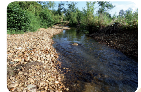
La Longuève (Dollon, Duneau - 72) après travaux.
