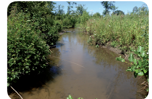
La Longuève (Dollon, Duneau - 72) avant travaux.
