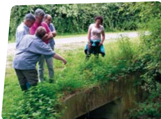
Bruno GUERRERO, technicien de rivière, explique les travaux réalisés.
