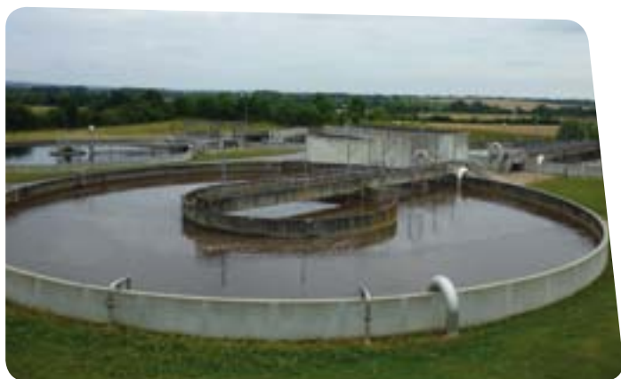
Station d'épuration de l'agglomération d'Alençon. Source : SATTEMA/AF.
