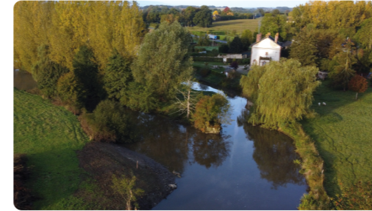
La Sarthe à Condé-sur-Sarthe (61) après le démantèlement du seuil situé sur le site de l'ancien moulin de la Randumière.
