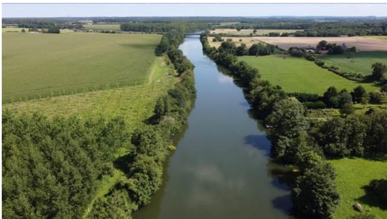
Photo prise sur la Sarthe aval au niveau de la commune de Dureil (72) via le drone acquis par le SBS (août 2021)
