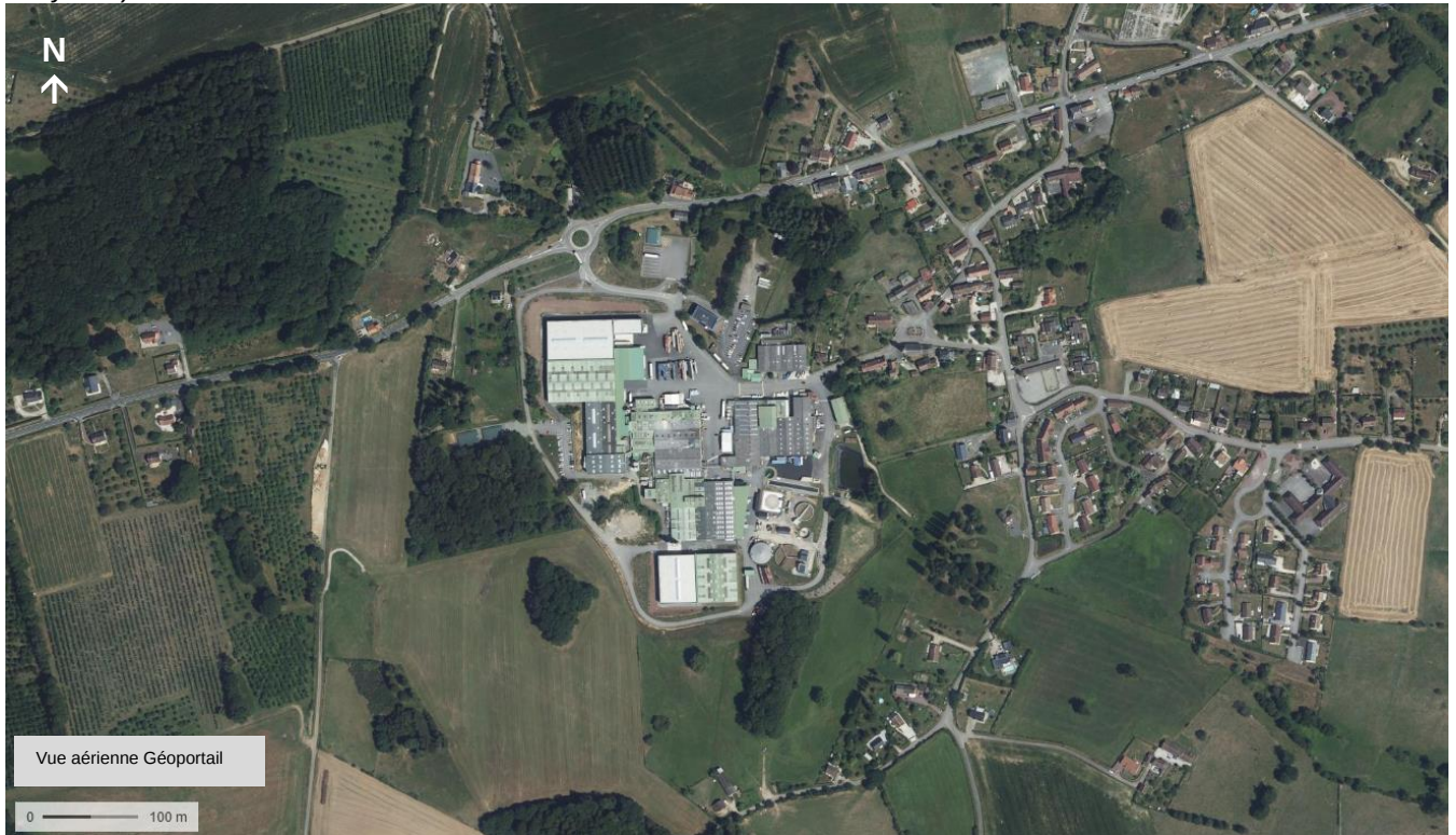
Figure 29 : Vue aérienne du site et de son voisinage
