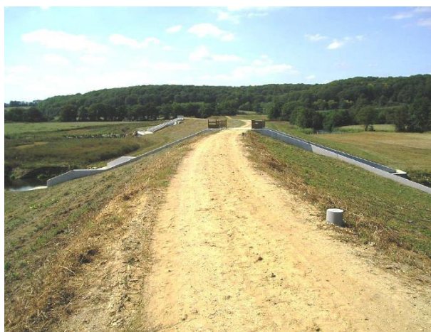
Figure 44 – Digue de protection – ouvrage de Margon (CC du Perche)
