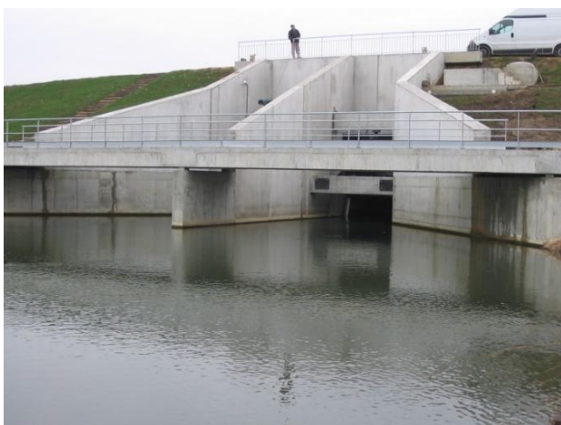
Figure 43 – Pertuis vanné de l'ouvrage de Margon (CC du Perche)
