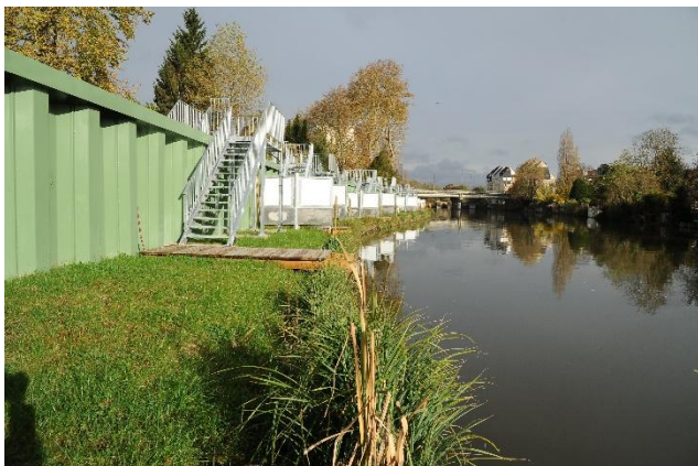
Figure 40 – Digue Crétois (Le Mans Métropole)
