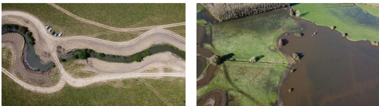
Figure 54 – Zones d'expansion de crue sur la vallée de la Sarthe en amont d'Alençon - travaux et mise en eau de la ZEC à l'hiver 2023 (EPTB Sarthe 2021)
