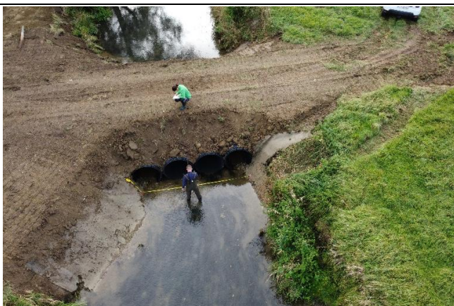
Réalisation d'un jaugeage hydraulique sur la Sarthe (septembre 2023)
