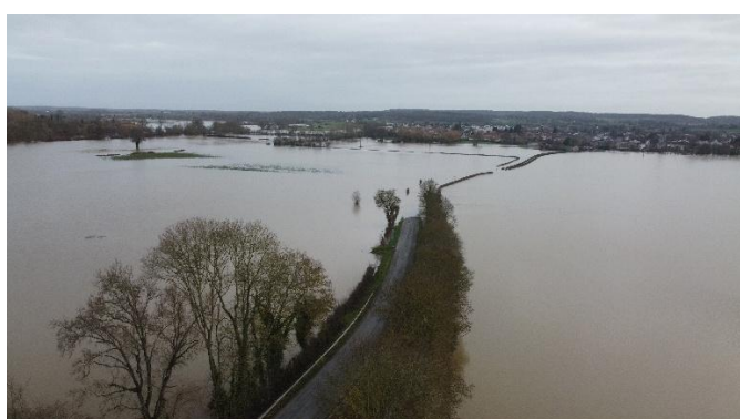
Figure 7 – La Sarthe à Neuville-sur-Sarthe - 72 (EPTB Sarthe)
