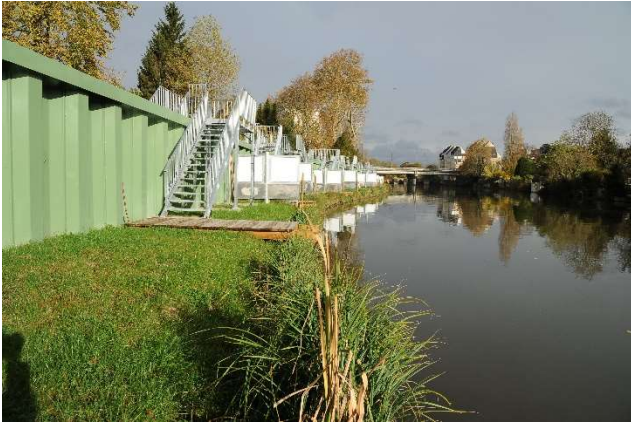
Figure 39 – Digue Crétois (Le Mans Métropole)
