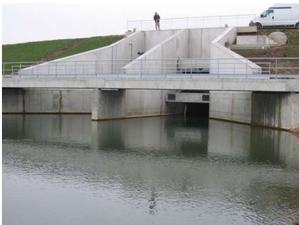
Figure 42 – Pertuis vanné de l'ouvrage de Margon (CC du Perche)
