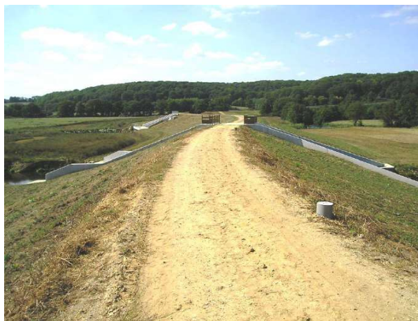
Figure 43 – Digue de protection – ouvrage de Margon (CC du Perche)
